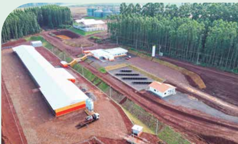
CTA foi construído em Cafelândia, onde a Cooperativa está sediada: estrutura moderna para testes de manejo e treinamentos
