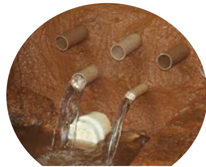
E depois da restauração
